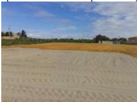
Figura 3: Aplainamento do terreno para construção de casa
