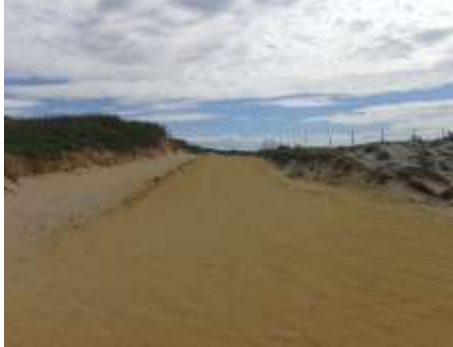
Figura 2: Construção de estrada sobre a duna
