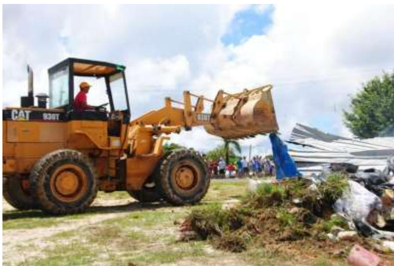
Figura 03: Imagem retirada durante a destruição dos abrigos improvisados
