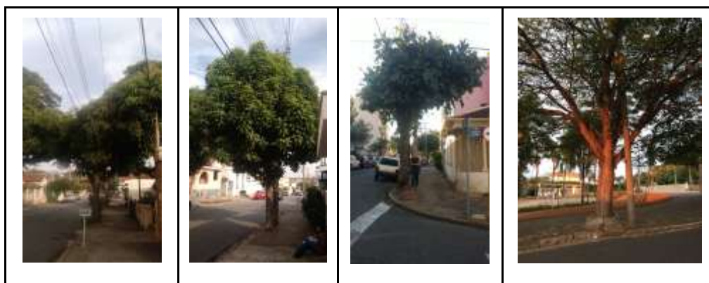
Figura 3. Conflitos das árvores com a fiação elétrica
