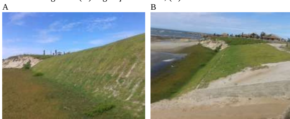
Figura 6: (A) vegetação em duna, (B) vista do talude
