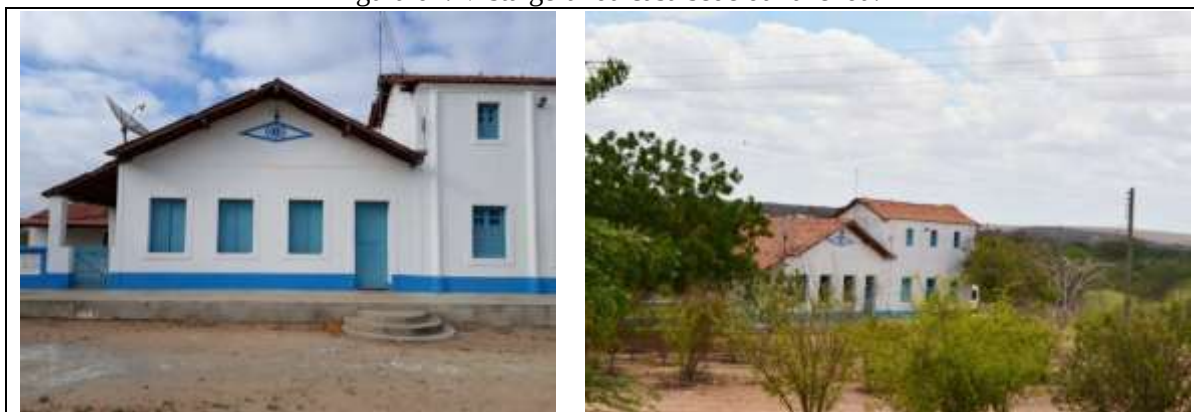
Figura 02. Vista geral da casa sede da fazenda.
